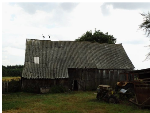
Rys. 1. Wyroby azbestowo – cementowe: płyty faliste, płyty płaskie, typ „Karo” (źródło: materiały własne)
