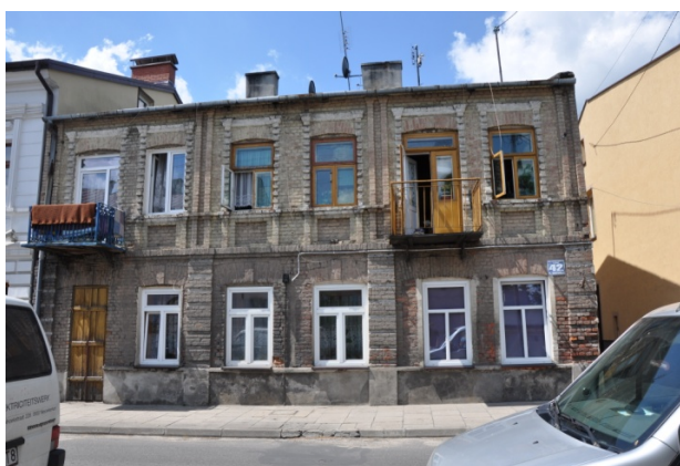
Kamienica, Żychlin ul. Narutowicza 42
