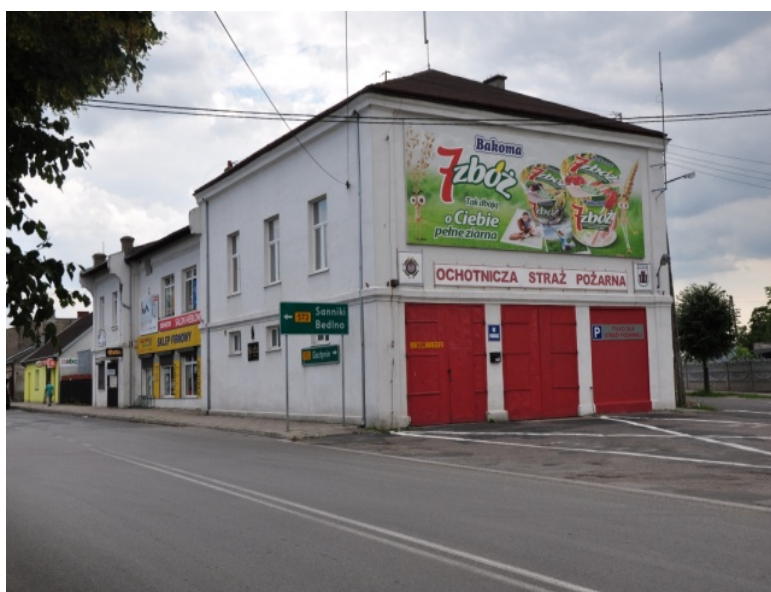
Budynek Straży Pożarnej Żychlin Pl. Wolności 4
