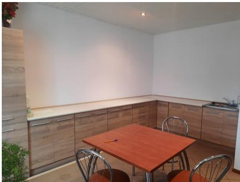
Świetlica wiejska w Kaczkowiznie w trakcie termomodernizacji oraz odnowione wnętrze.
