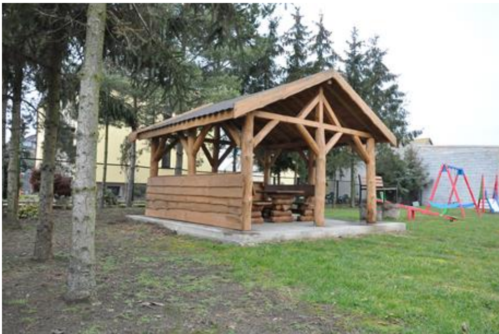
Teren rekreacyjny w miejscowości Żabików wraz z zamontowaną altaną ogrodową.
