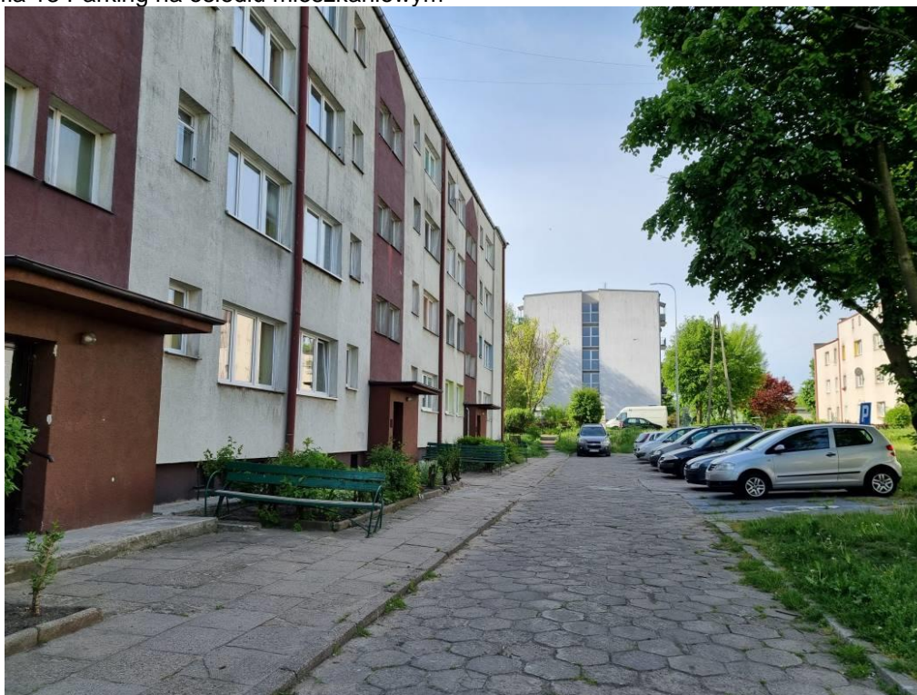
Fotografia 13 Parking na osiedlu mieszkaniowym
