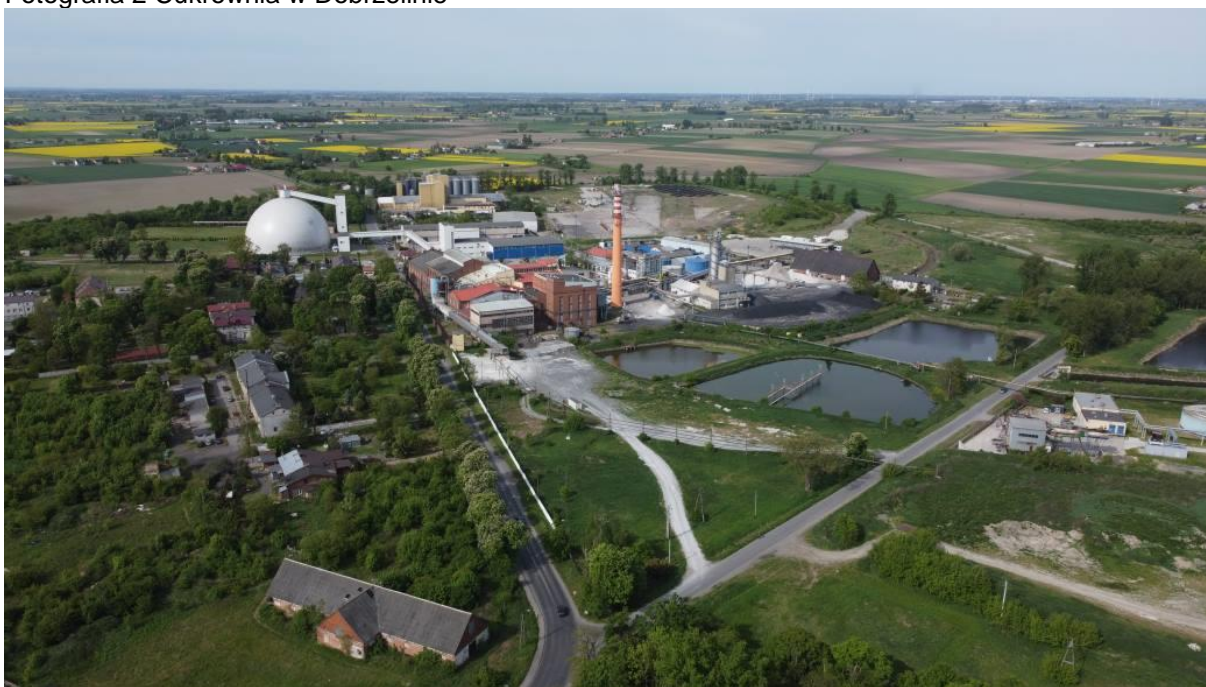
Fotografia 2 Cukrownia w Dobrzelinie
