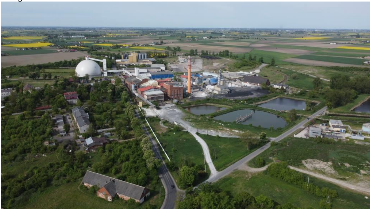
Fotografia 2 Cukrownia w Dobrzelinie
