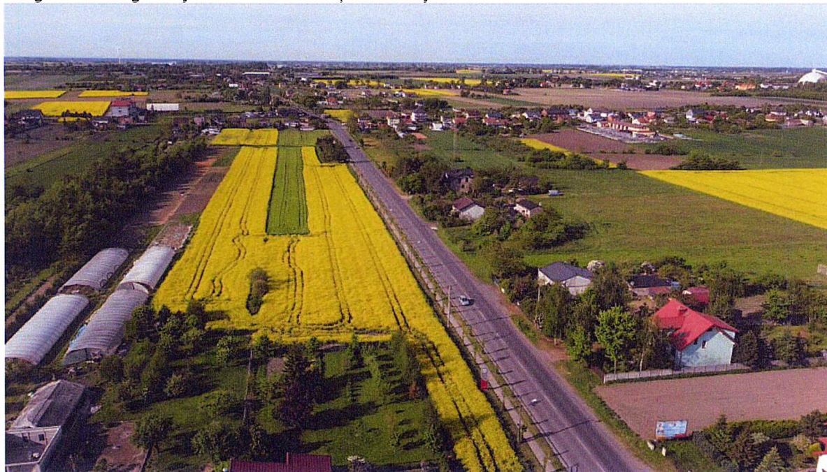
Fotografia 9 Droga z Żychlina w kierunku południowym
