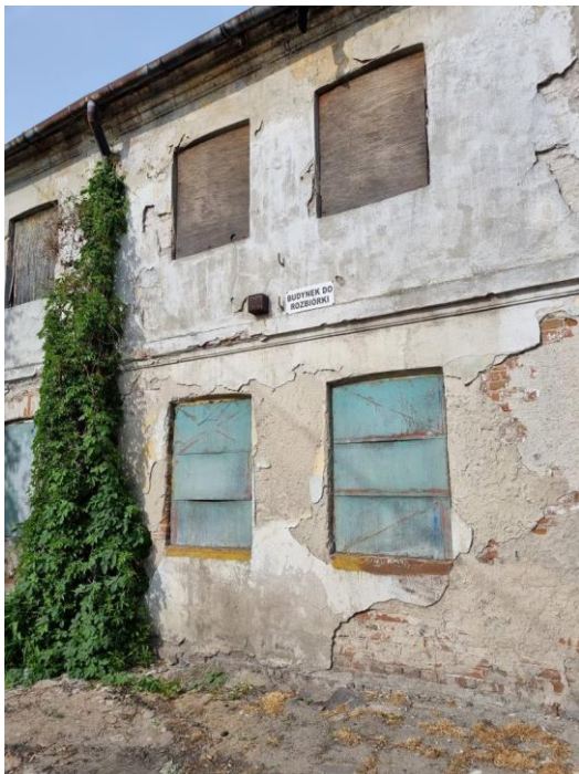
Fotografia 34. Budynek przeznaczony do rozbiórki
