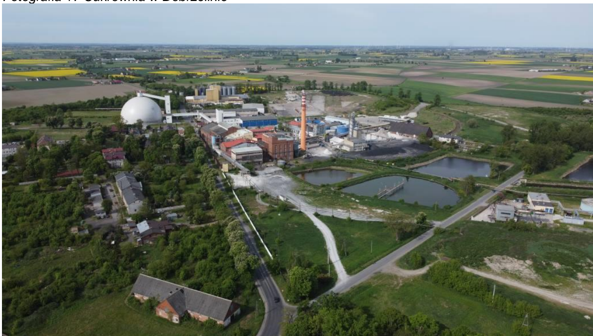
Fotografia 17 Cukrownia w Dobrzelinie
