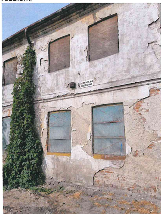
Fotografia 34. Budynek przeznaczony do rozbioru
