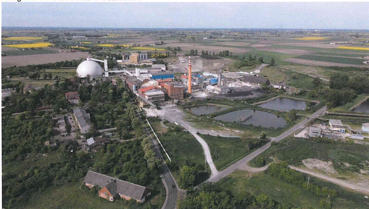
Fotografia 17 Cukrownia w Dobrzelinie
