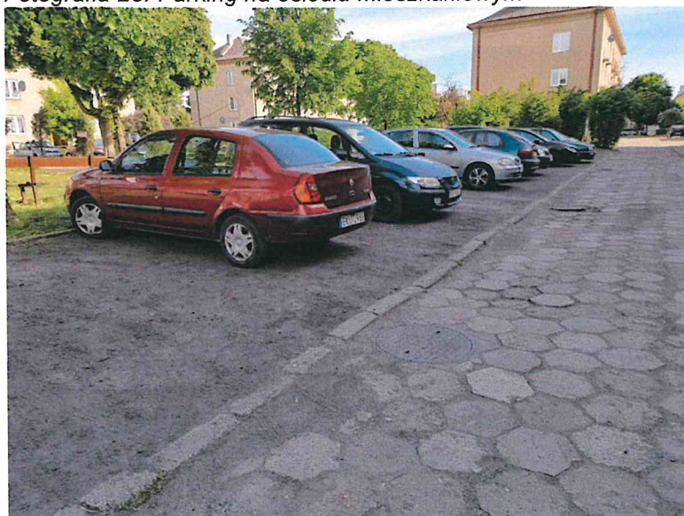
Fotografia 28. Parking na osiedlu mieszkaniowym
