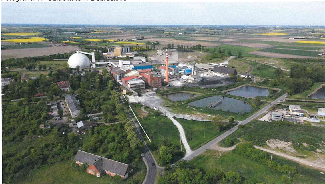
Fotografia 17 Cukrownia w Dobrzelinie
