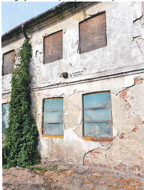
Fotografia 34. Budynek przeznaczony do rozbiórki
