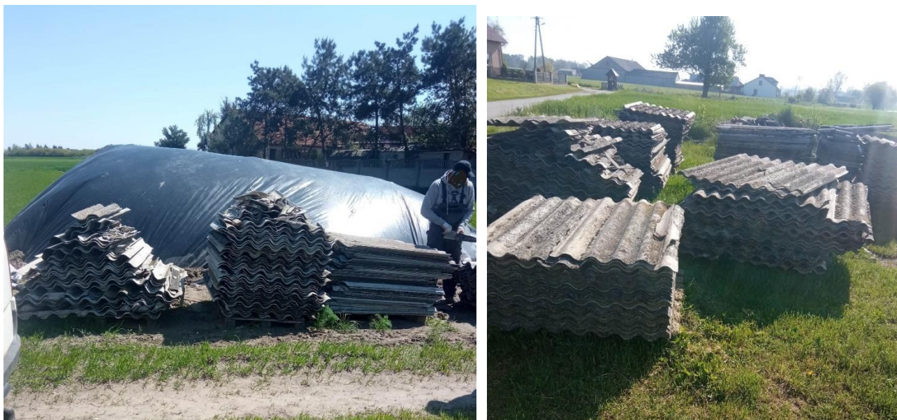
Rozebrane elementy dachów z materiałów zawierających azbest.
