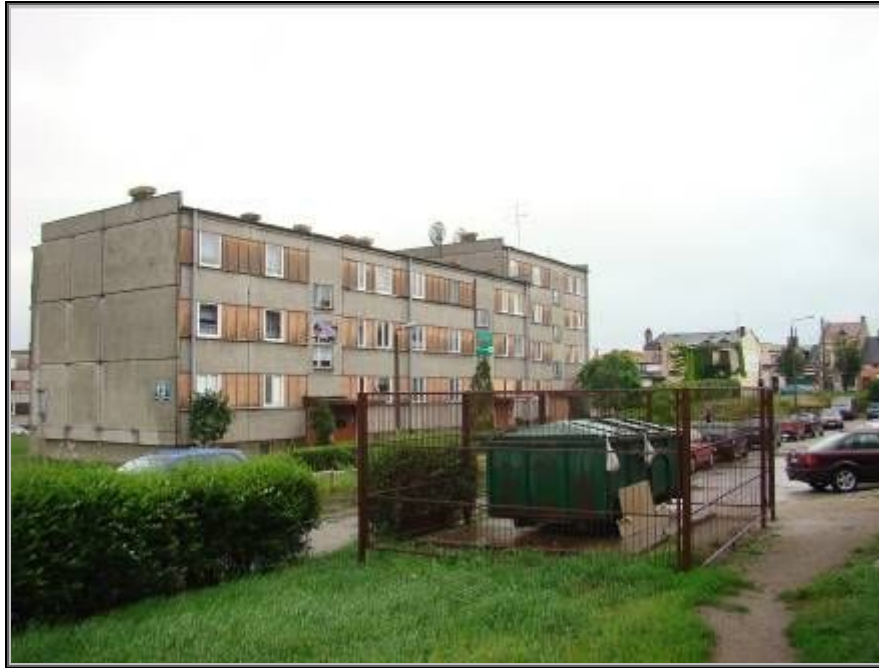
Ryc. 33 Blok mieszkalny na Os. Traugutta
