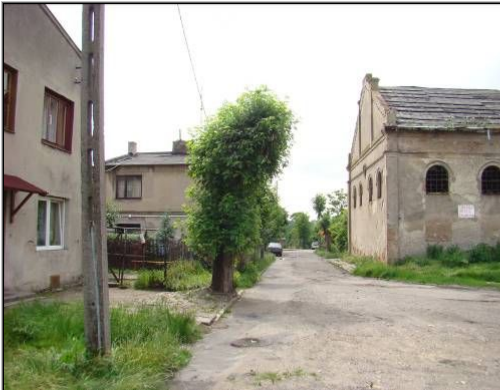
ryc. 54 Zabudowa przy ul. Złotej i Zdrojowej
