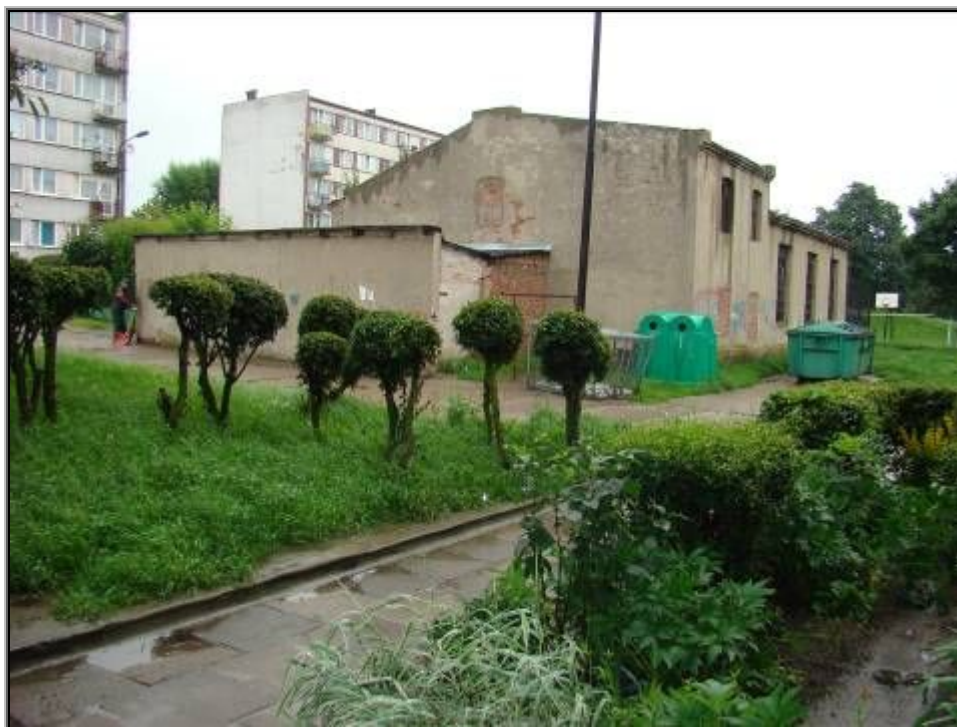
ryc. 37 zdezastowany obiekt na os. Traugutta
