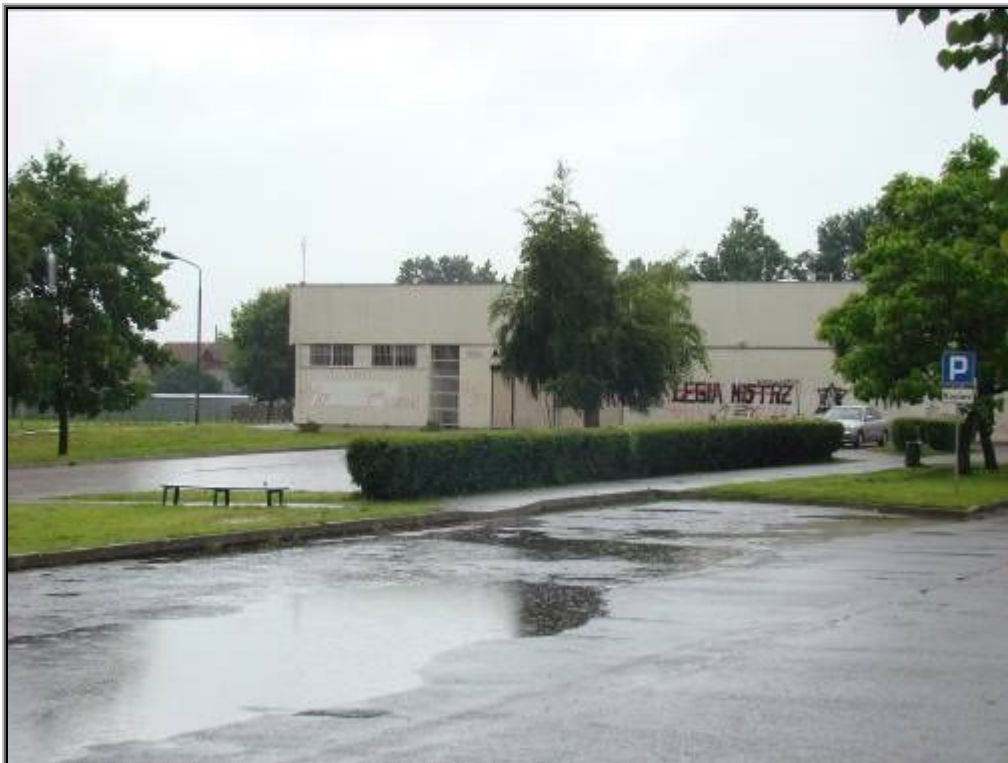
ryc. 39 Pawilon handlowy na osiedlu przy ul. Łąkowej
