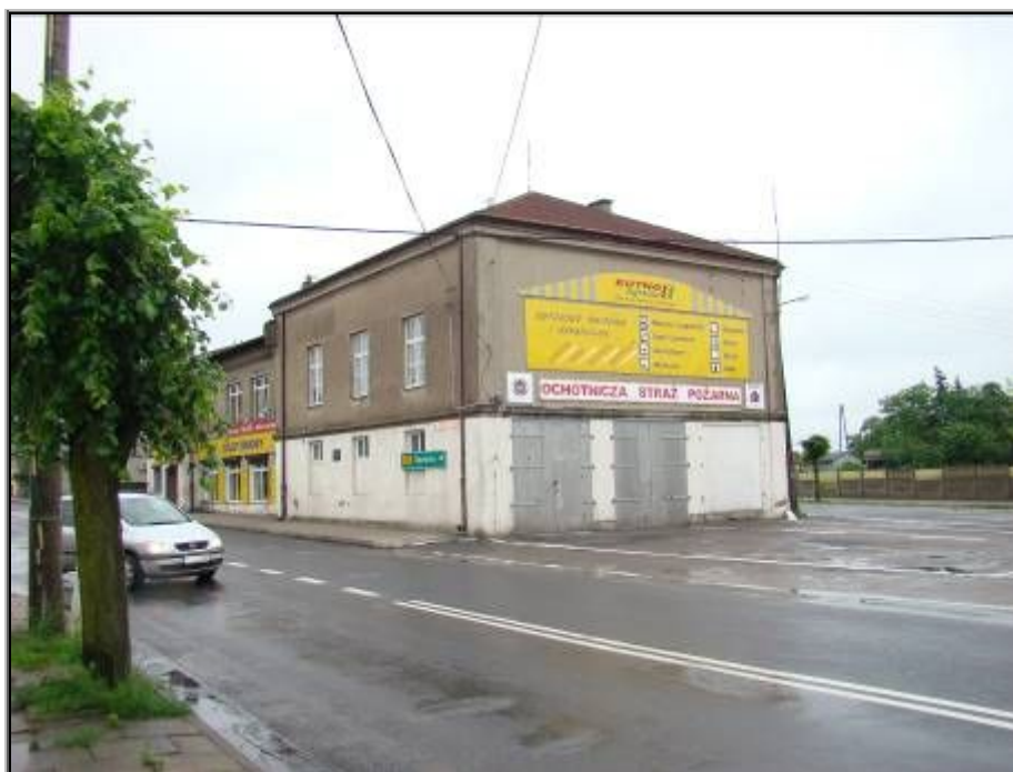
ryc. 51 Wymagający rewitalizacji budynek strażnicy
